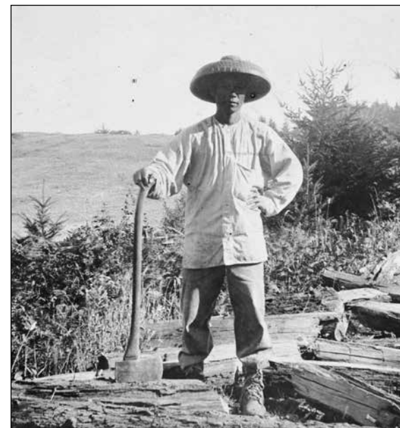
题注:尽管俄勒冈华人遍布多个重要行业,这一群体仍面临着重重的联邦和州级种族主义法律,这些法律旨在阻止移民、组建家庭和经济流动。许多人找到途径,成功规避了这些他们认为不公正、不合理的法律。图中场景是 1885 年前后,一名华工在俄勒冈州波特兰某工地上的留影。
